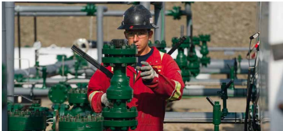
↑ 加拿大Groundbirch致密气田的工作场景。
