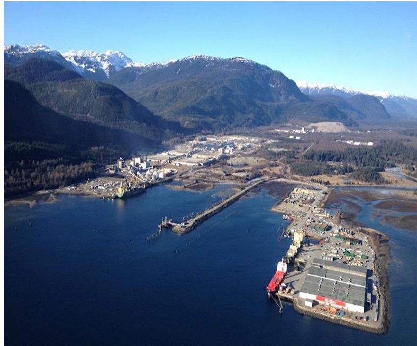
LNG Canada – industrial site view
